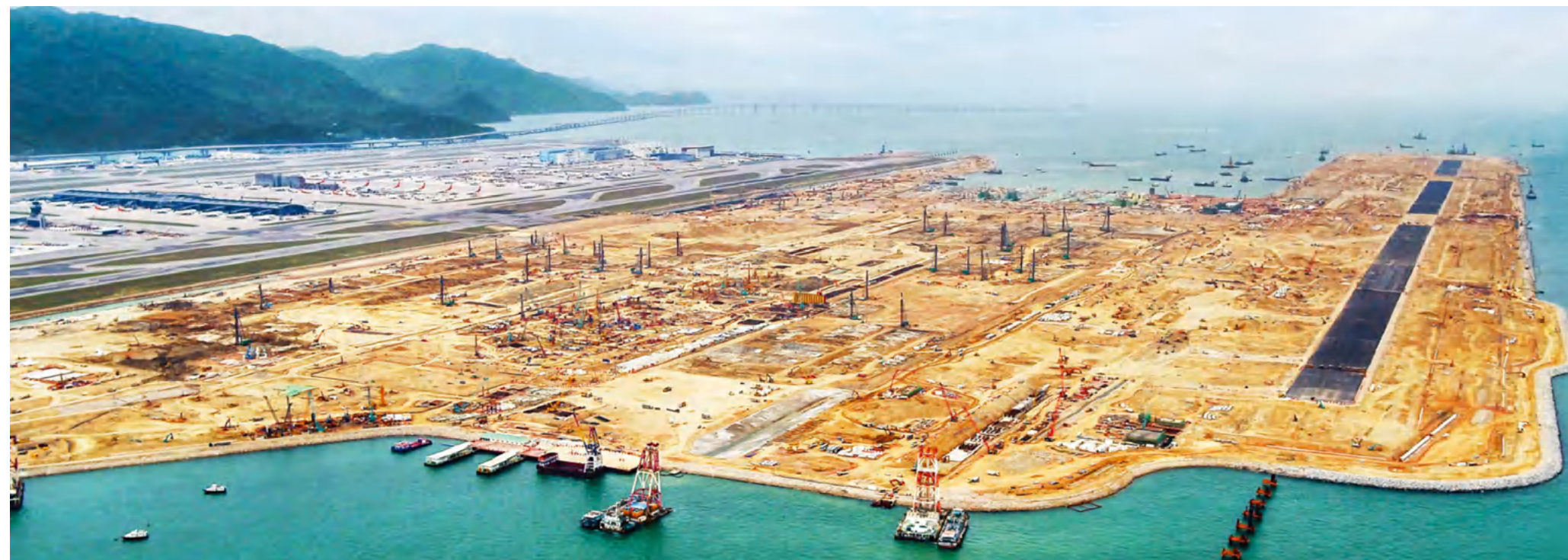
香港国际机场第三跑道建设中
